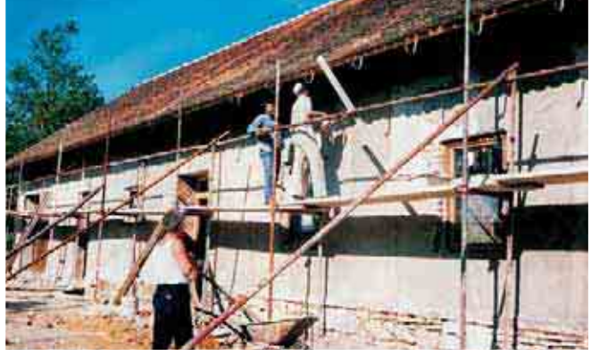
Završetak obnove '90-ih
